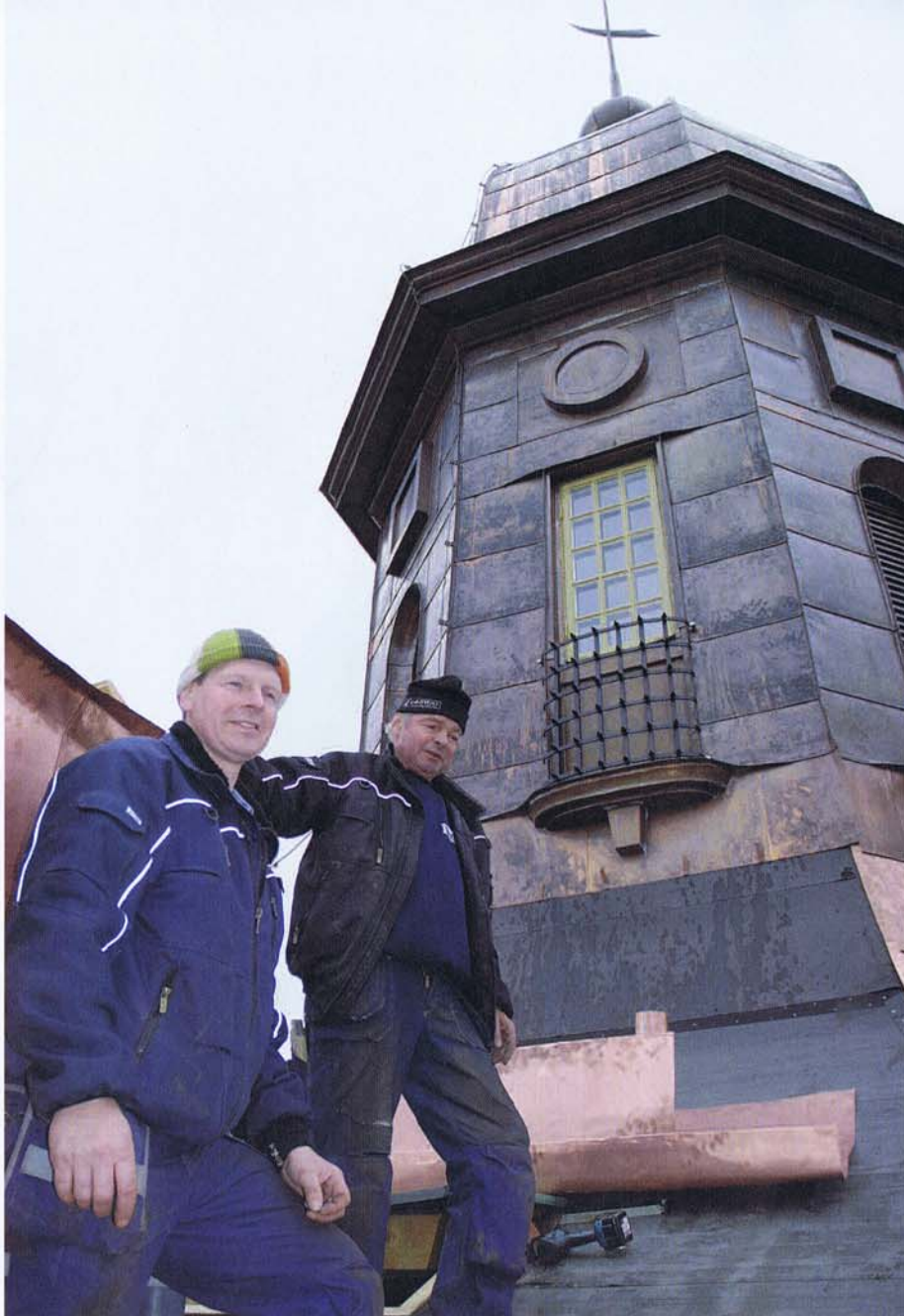
Mats Lönnberg och Sylve Ledén byter ut den gamla kopparbeklådnaden på Carlanderska sjukhusets huvudtorn. Övriga inblandade i arbetet är Ulf Nilsson och lärlingen Linus Lundberg.
